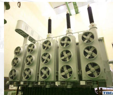
Трансформаторы на 110кВ и 220кВ;
