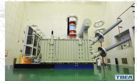
Трансформаторы на 330кВ–500 кВ;
